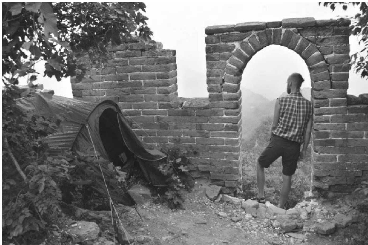
FOT. ALEKSANDRA STUDZIŃSKA - WIELKI MUR CHIŃSKI
